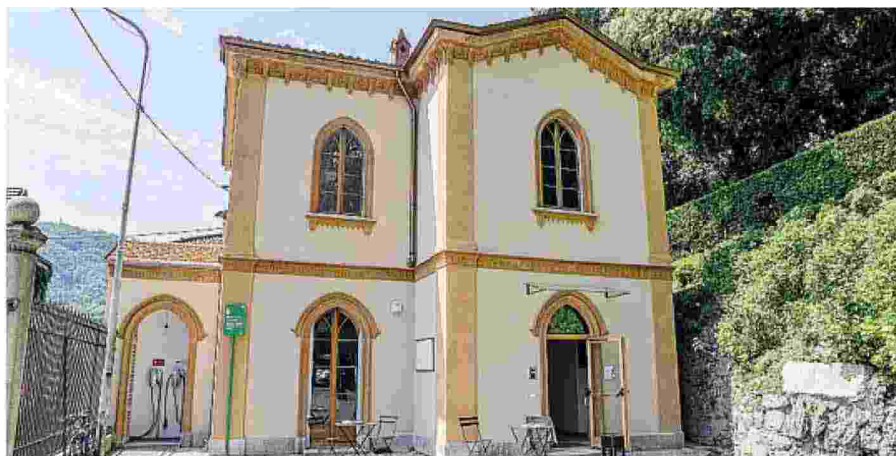
L'ex portineria di Villa del Grumello, appena restaurata e ora disponibile BUTTI
