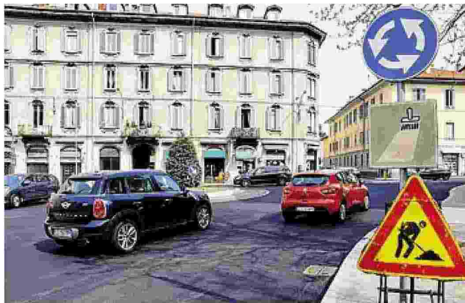
L'asfalto appena posato nella zona della nuova rotonda BUTTI
