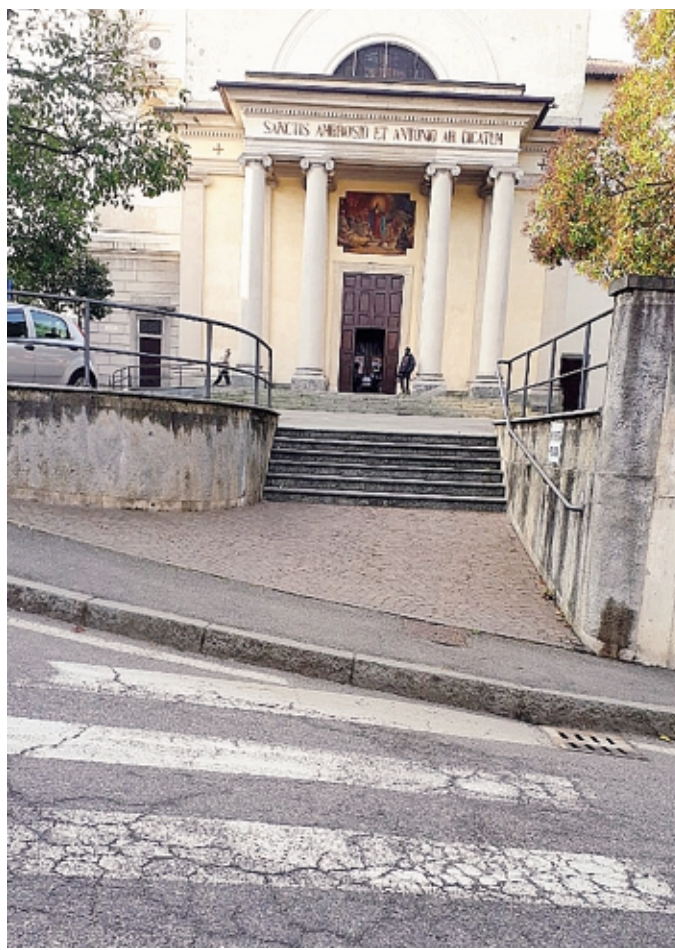
Il marciapiede davanti alla chiesa
