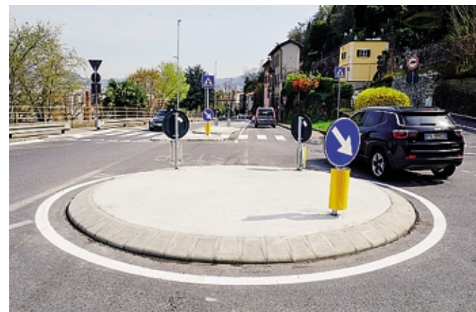
La rotonda ultimata proprio in queste ore BUTTI
