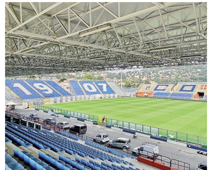
Buona parte dello stadio non è attualmente utilizzata
