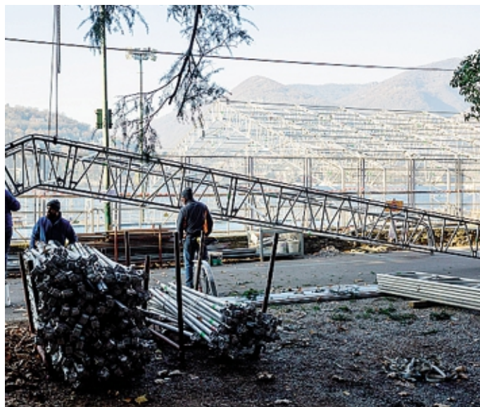
La copertura provvisoria montata in queste ore in viale Geno
